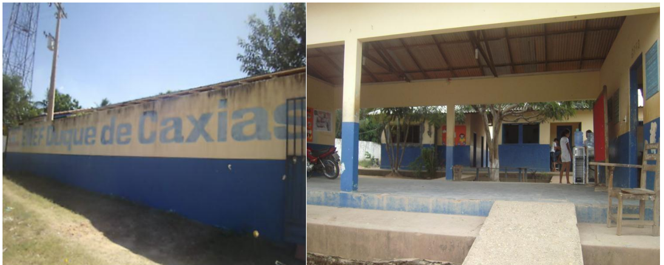
Figura 1 – Fachada e interior da Escola Duque de Caxias
