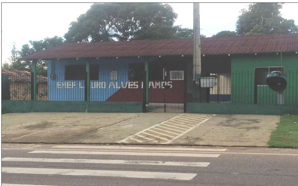
Figura19- Escola da comunidade do Livramento.
