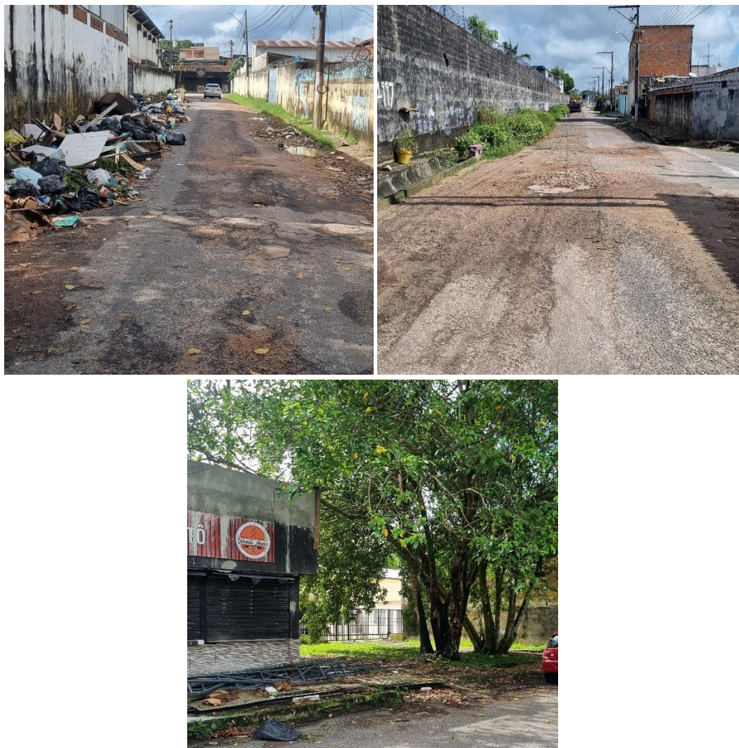
Figura 12 – Áreas com baixa infraestrutura no bairro da Cidade Nova, Ananindeua/PA.
