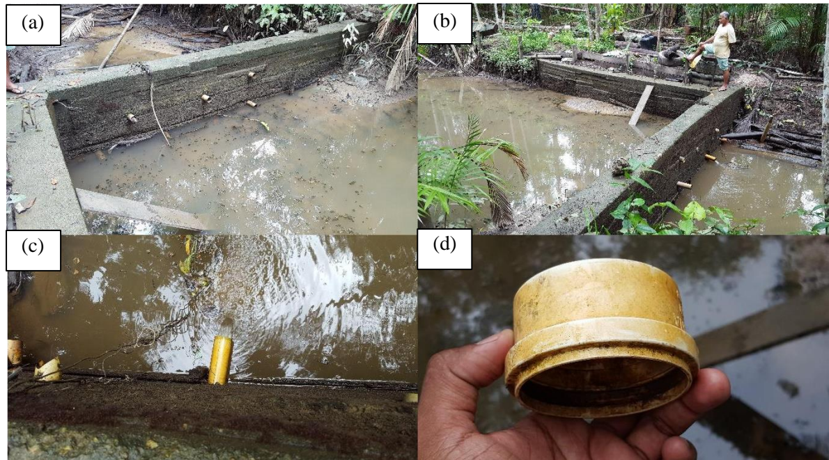
Figura 4 – Barragem de concreto construída em um viveiro de várzea. (a,b) barragem de concreto (c) sistema de drenagem (d) mostra o tampão de PVC utilizado nos tubos inferiores.
